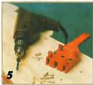
5 Отверстия под шкранты сверлят с помощью специального кондуктора и сверла, снабженного ограничителем глубины сверления.
